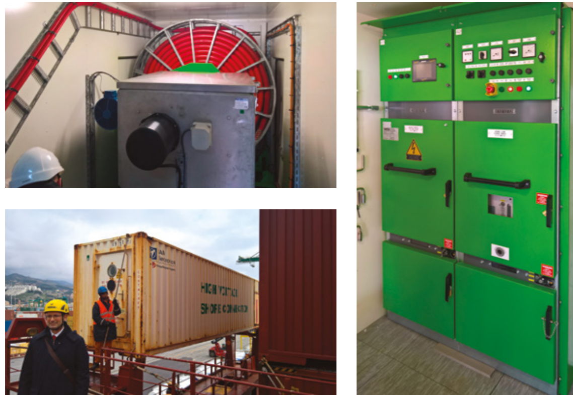
Fig.27 Alimentazione navi portacontainer
