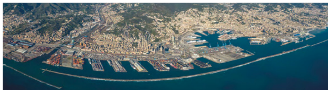
Fig.1 Vista aerea del Porto di Genova
