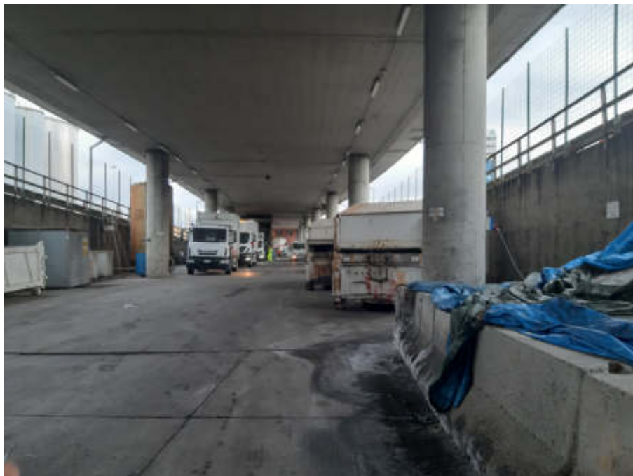
Figura 10 - Stazione di trasferimento e compattazione dei rifiuti
