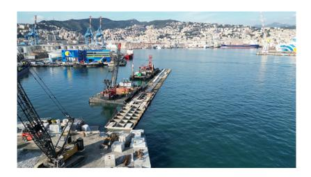
A Calata Olii Minerali, nel centro del porto storico dedicato al traffico merci, si sono recentemente concluse le operazioni di allineamento del quinto cassone, l'ultimo necessario a completare la riprofilatura della banchina est che consentirà un attracco più agile anche alle navi cisterna da 130 metri. Questa milestone raggiunta segna un significativo avanzamento del complesso di interventi di riconfigurazione della calata la cui conclusione è prevista entro l'estate di quest'anno.
