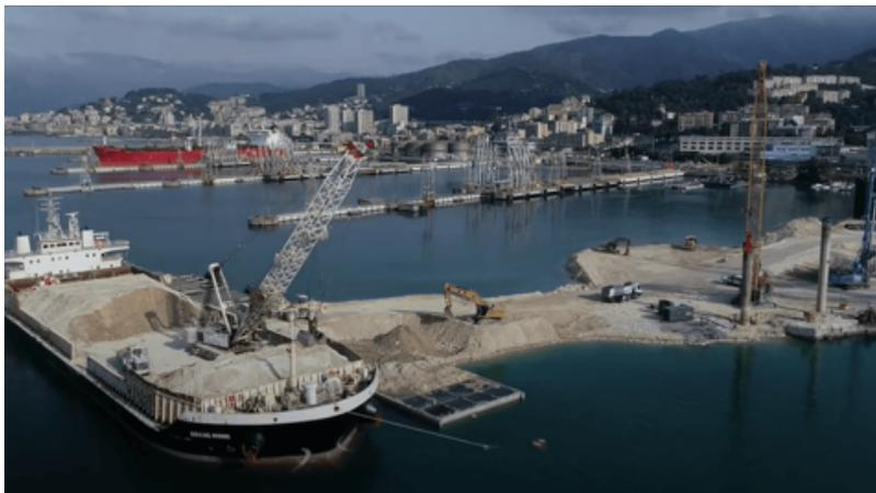
**Proseguono velocemente i lavori per la costruzione della nuova calata a mare dei cantieri navali di Sestri Ponente mediante il versamento di materiale inerte lapideo proveniente dal comprensorio cave di Marina di Carrara, per un quantitativo complessivo di circa 800mila tonnellate, e la cinturazione della colmata realizzata con cassoni cellulari di dimensioni pari a 14 x 33 metri.**
