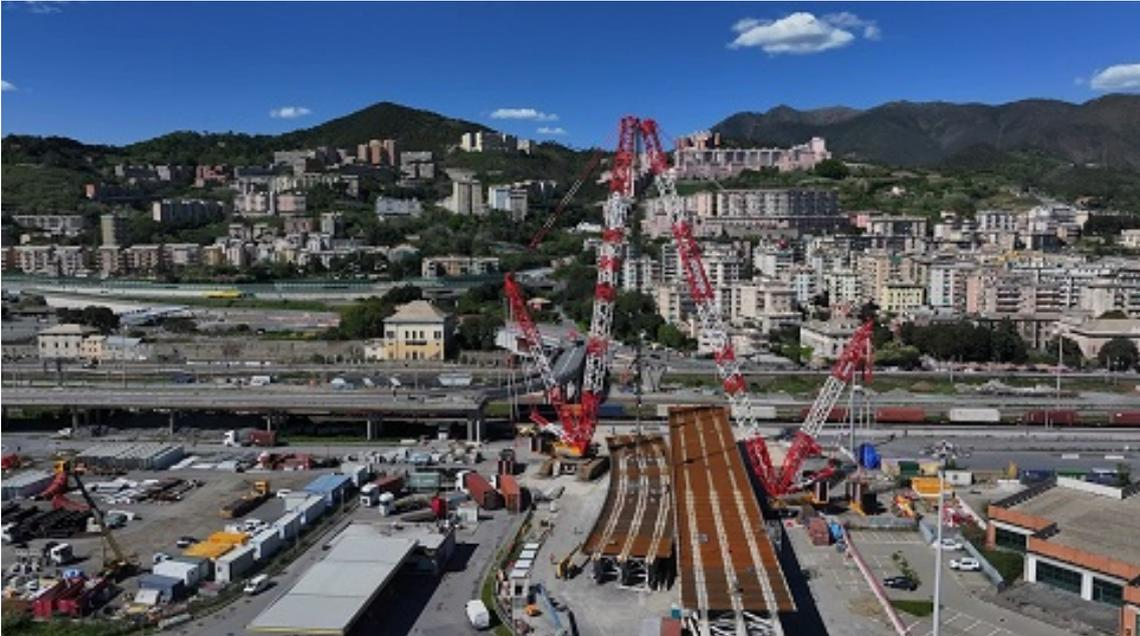
**Con il varo della campata numero 8, il nuovo viadotto di Pra' ha raggiunto il 60% del suo completamento. Le spettacolari operazioni di posizionamento dell'impalcato lungo oltre 78 metri e con un peso di 510 tonnellate sono state completate con successo. A maggio il bis con il varo della struttura a scavallo di via Pra'.**
