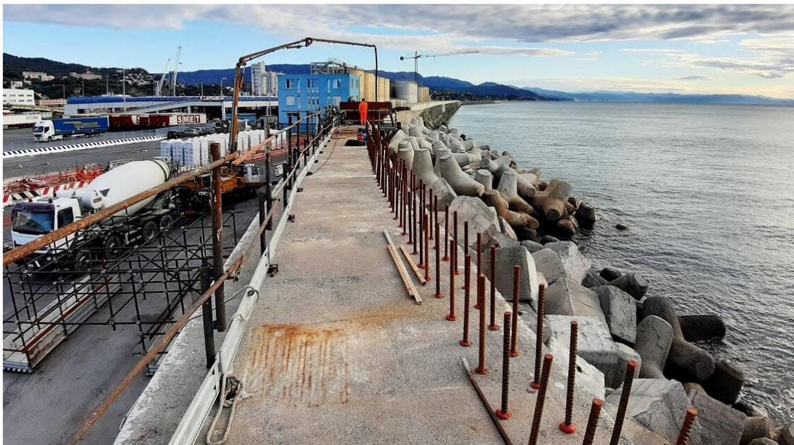
Ripresi, a seguito della pausa estiva, i lavori di [ripristino delle opere foranee di difesa delle coste di Savona e Vado Ligure \(P.768\)](#) tramite il potenziamento della diga con la posa di tetrapodi e il sopralzo della quota del muro paraonde.
