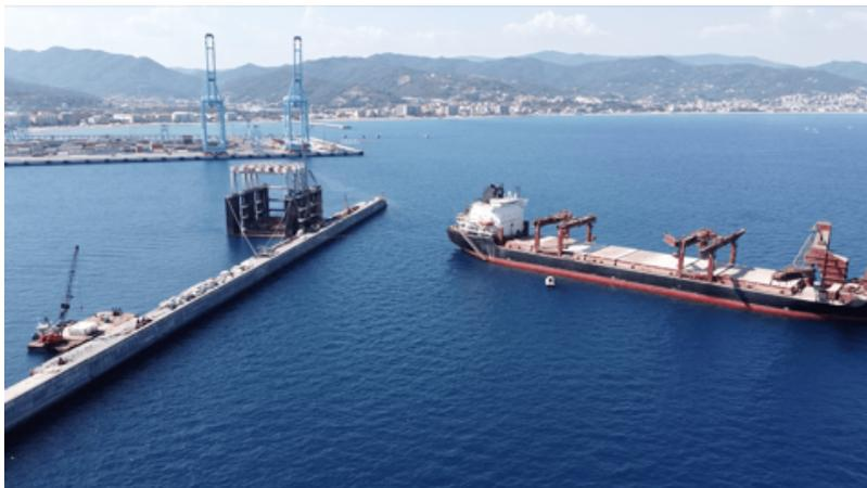
**Proseguono i lavori di realizzazione della nuova diga di Vado Ligure, dove l'imponente impianto galleggiante per la prefabbricazione dei cassoni è stato raggiunto dalla bulk carrier di quasi 190 metri Bontrup Pearl, capace di trasportare oltre 32.000 tonnellate di materiale.**
