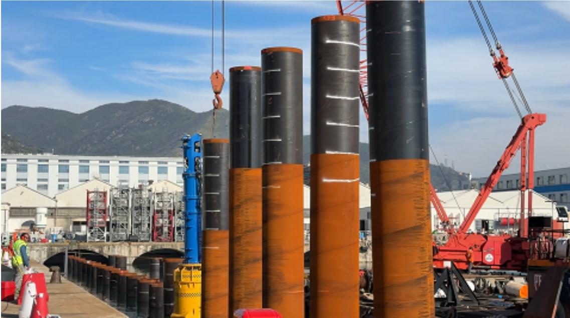
**Proseguono a Genova Sestri Ponente i lavori per la nuova banchina di allestimento destinata a potenziarne l'attività industriale, attraverso l'infissione di 269 pali di fondazione con tecniche avanzate e sicure.**
