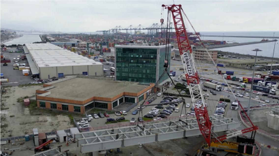
**È stato completato con successo il varo della prima campata del nuovo viadotto nel cantiere all'interno dell'area portuale. Con una lunghezza complessiva di 56 metri e un peso di circa 240 tonnellate, la campata numero 6 è stata varata senza intoppi e in rapido tempo.**
