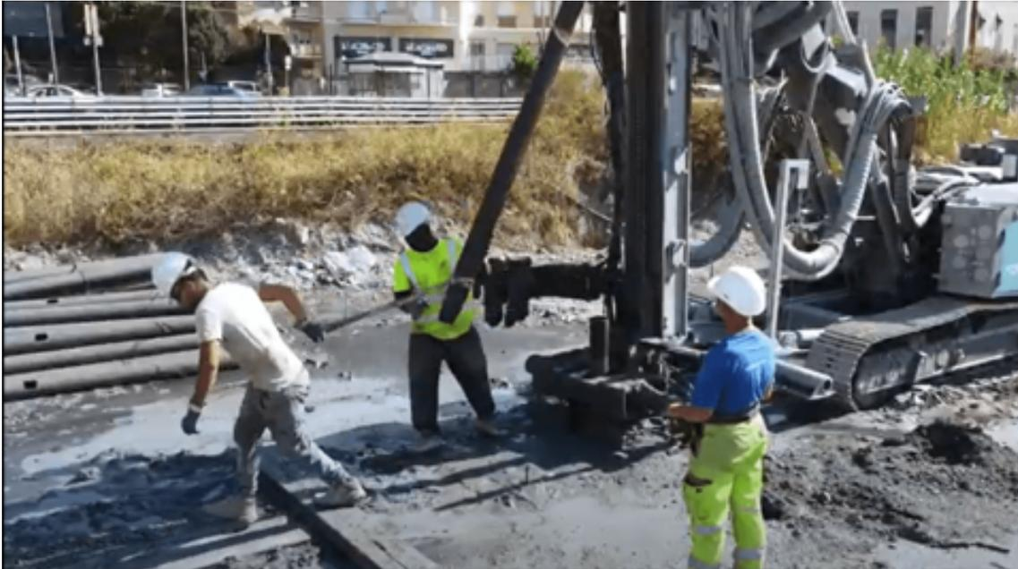
**Terminate le operazioni preliminari e riconfigurato il cantiere su via Aurelia per ridurre l'interferenza con la viabilità urbana, procedono i lavori per la realizzazione delle fondamenta delle pile che sosterranno il nuovo viadotto a tre corsie e a doppio senso di marcia. Il tracciato ridisegnato snellisce l'accesso al terminal contenitori di Genova Pra' e permette l'ampliamento del parco ferroviario.**
