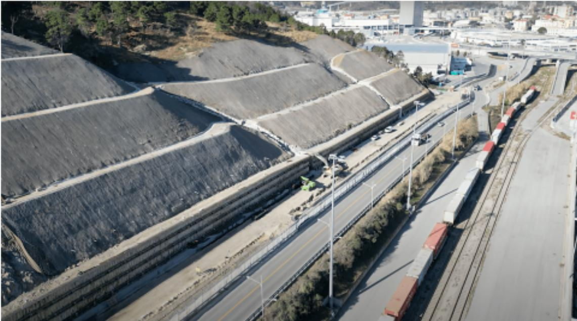
Procedono a pieno ritmo i lavori di [ampliamento e potenziamento del parco ferroviario](#) Â a servizio del porto di Vado. Il nuovo parco sarà dotato di gru transtainer e di nuovi binari, agevolando e velocizzando le operazioni di carico e scarico dei treni.
