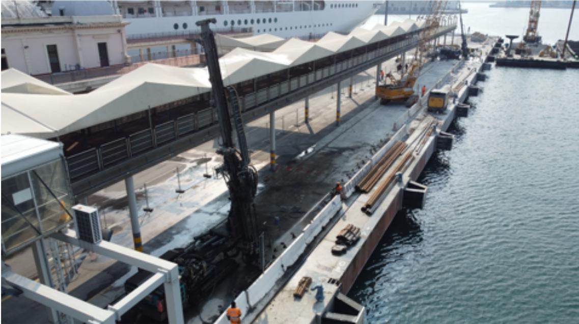
Sono in corso presso [il cantiere di Ponte dei Mille](#) le operazioni di jet grouting per concludere i lavori di consolidamento della banchina lato ponente.
