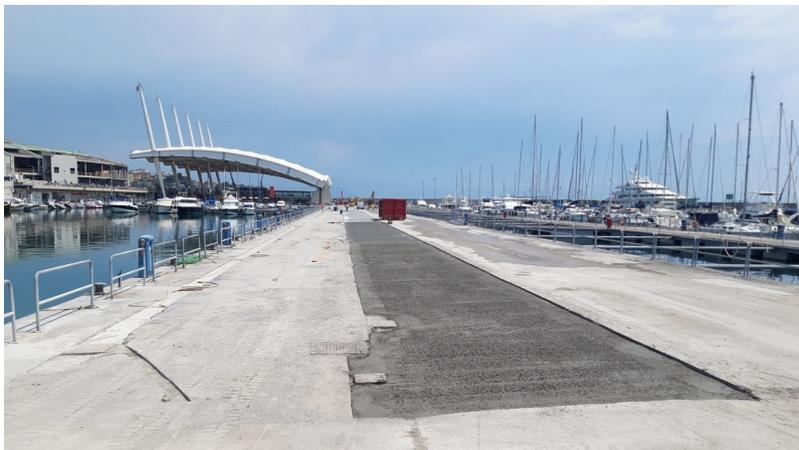
**Sono terminati i lavori di demolizione del muro paraonde sulla banchina «E» della Darsena Nautica e sono in corso gli interventi di predisposizione dei sottoservizi e della pavimentazione della banchina**
